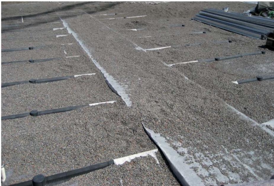
*Einbau der Optigrün-Kollektorelemente mit angeschlossenen Triangel-Wasserleitprofilen*
